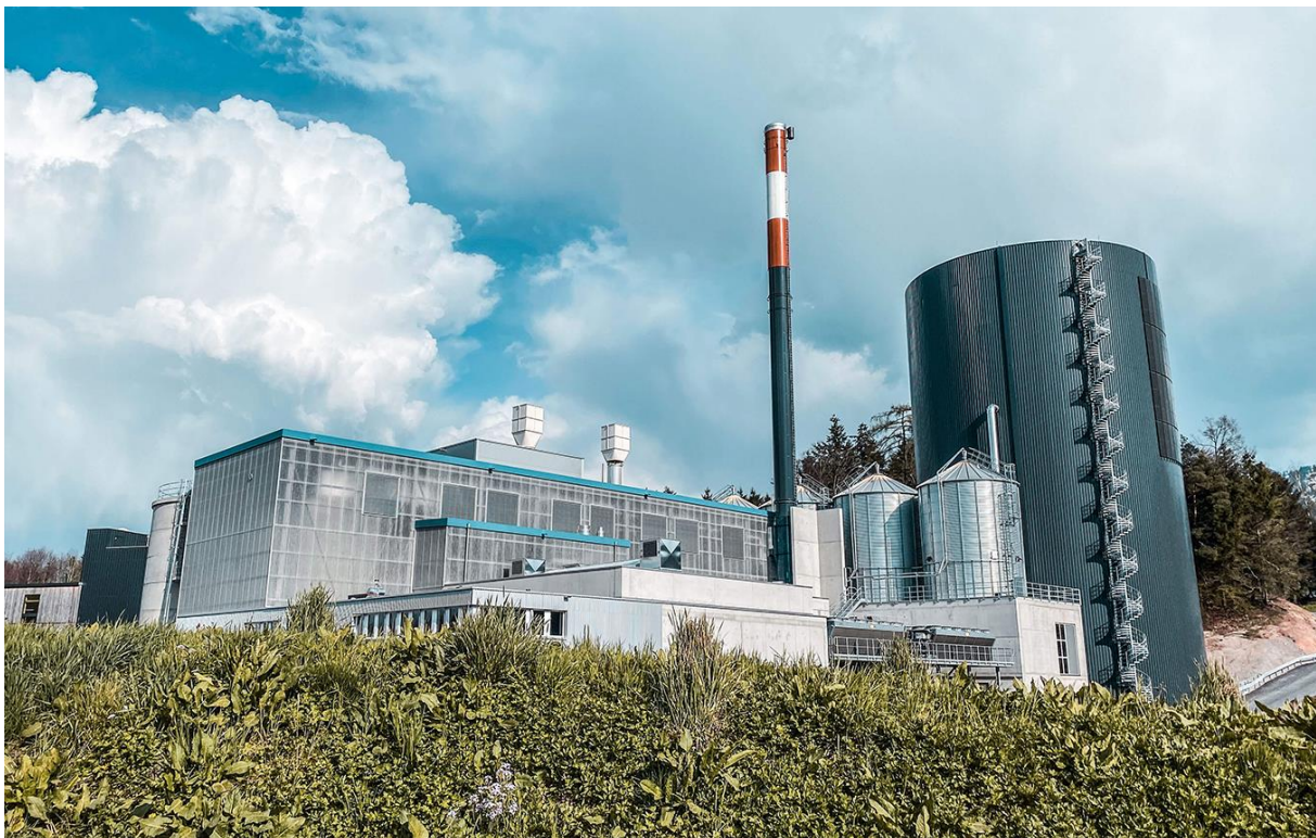
AGRO Energiezentrum Rigi und dem 45m hohem Speicherturm
